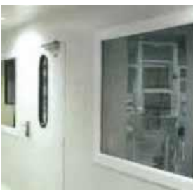
PC-300 ESD - PC 靜電消散(表面阻抗值10 6 ~10 8 )
